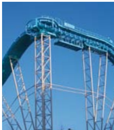
Montierte Drehstation einer Wasserbahn
