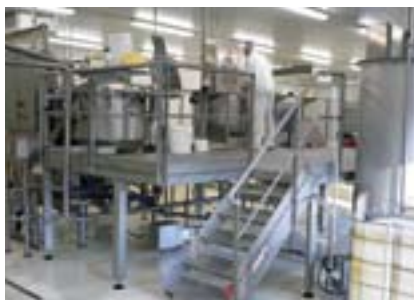
Inbetriebnahme einer Prozessanlage Processing facility installation
