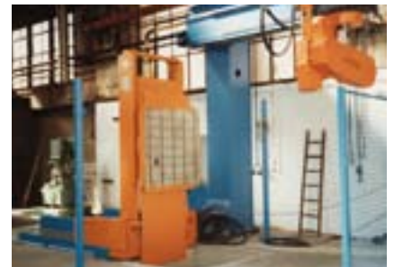
Montage CNC-Drehtisch mit Roboter On-site assembly CNC turntable with robotic unit
